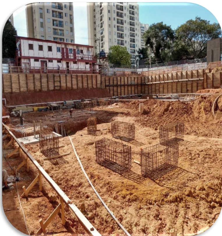
Armação dos blocos de fundação
