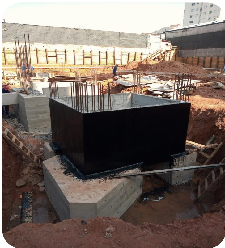
Impermeabilização do poço dos elevadores
