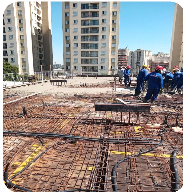
Concretagem da laje do 4º pavimento Torre A
