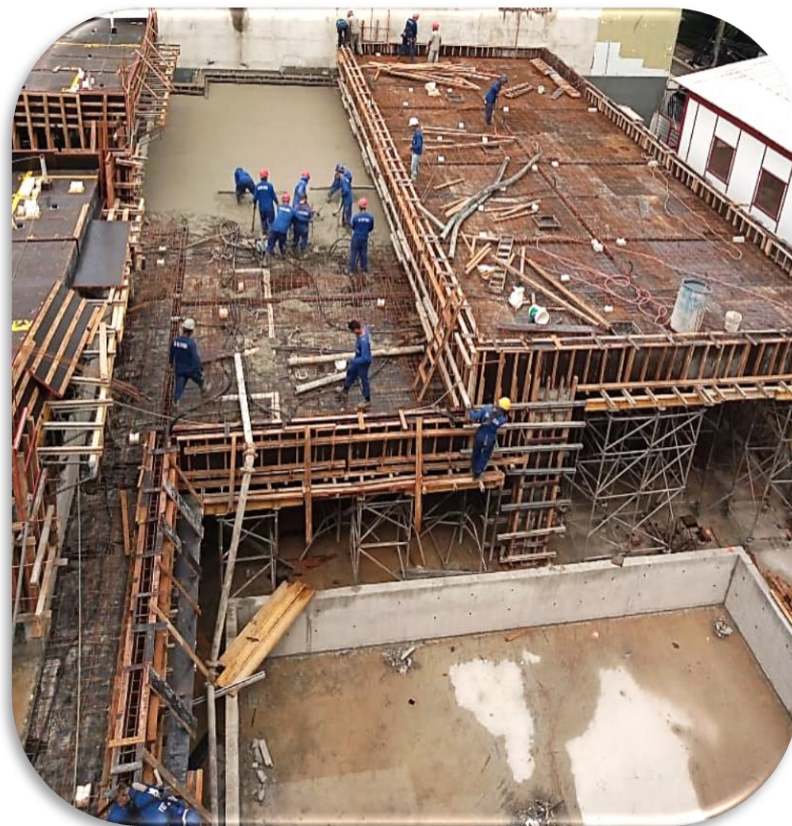
Concretagem da laje de periferia 1º pav. Torre B
