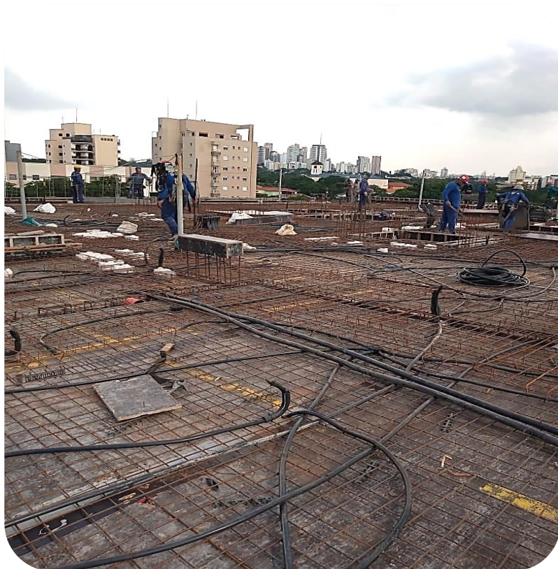
Vista Torre A . Laje do 4º pavimento
