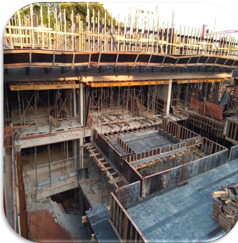
Vista Torre A , subindo pilares do 2º Pavimento e bandeja de proteção instalada
