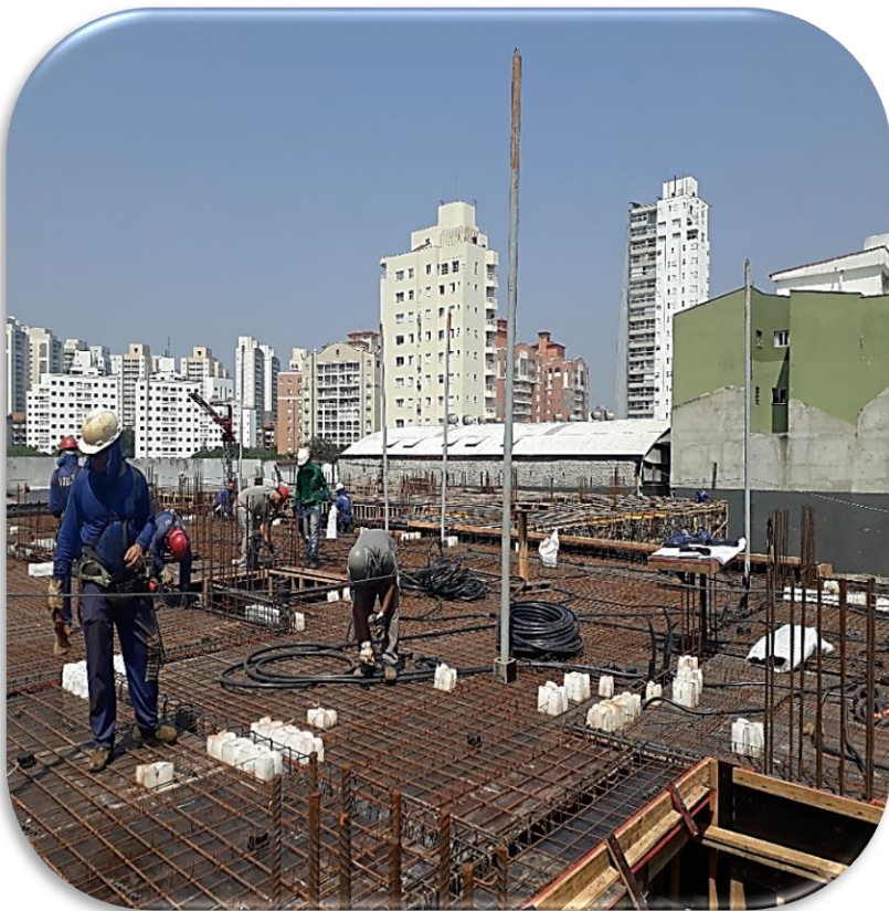
Armação da laje do 1º pavimento Torre A para ser concretada
