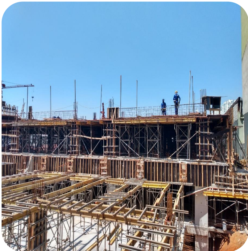
Vista Torre B. Armando a Laje do 1º Pavimento
