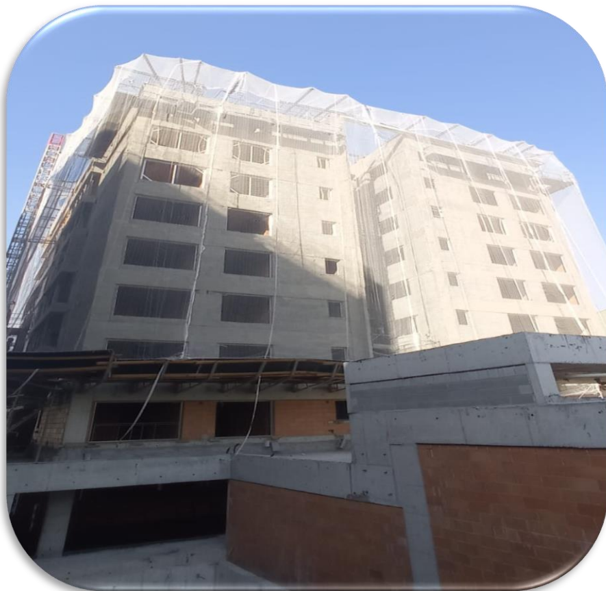
Fachada da torre - B
