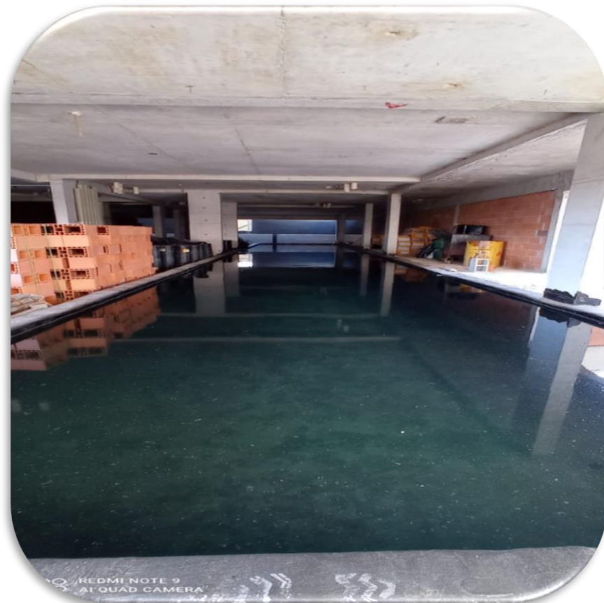
Teste de estanqueidade da piscina
