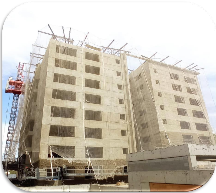
Fachada da torre B
