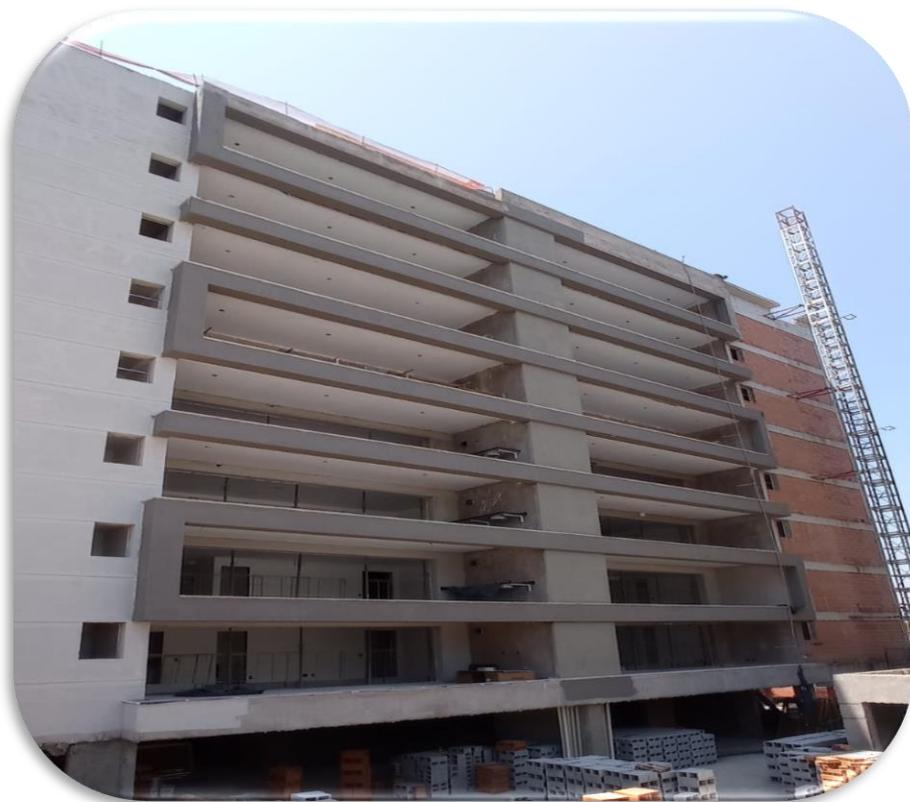
Fachada posterior com aplicação de seladora e fechamento de alvenaria para retirar cremalheira da Torre -A
