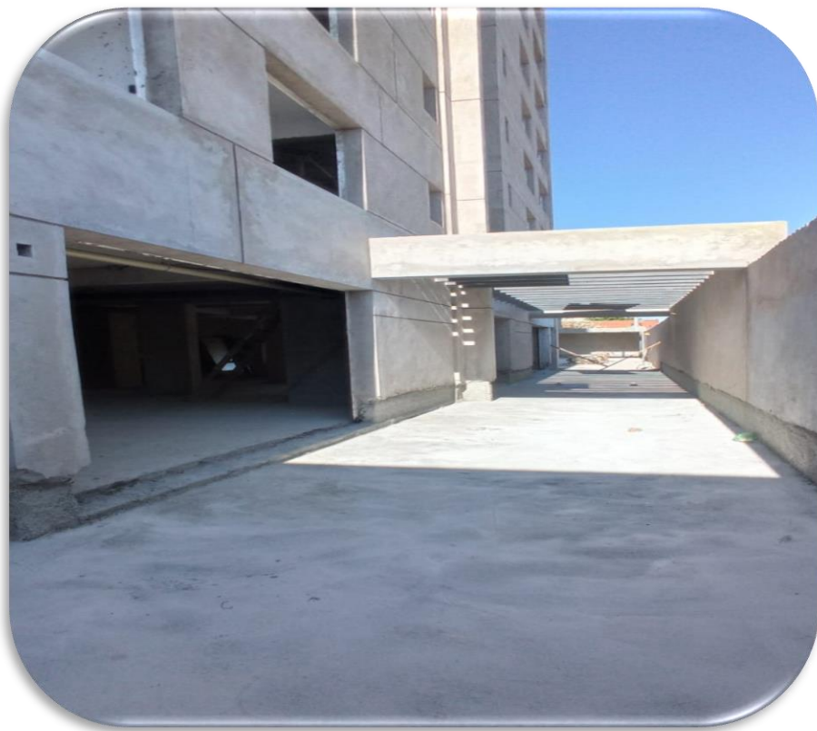
Revestimento de massa na lateral esquerda da Torre – B.
