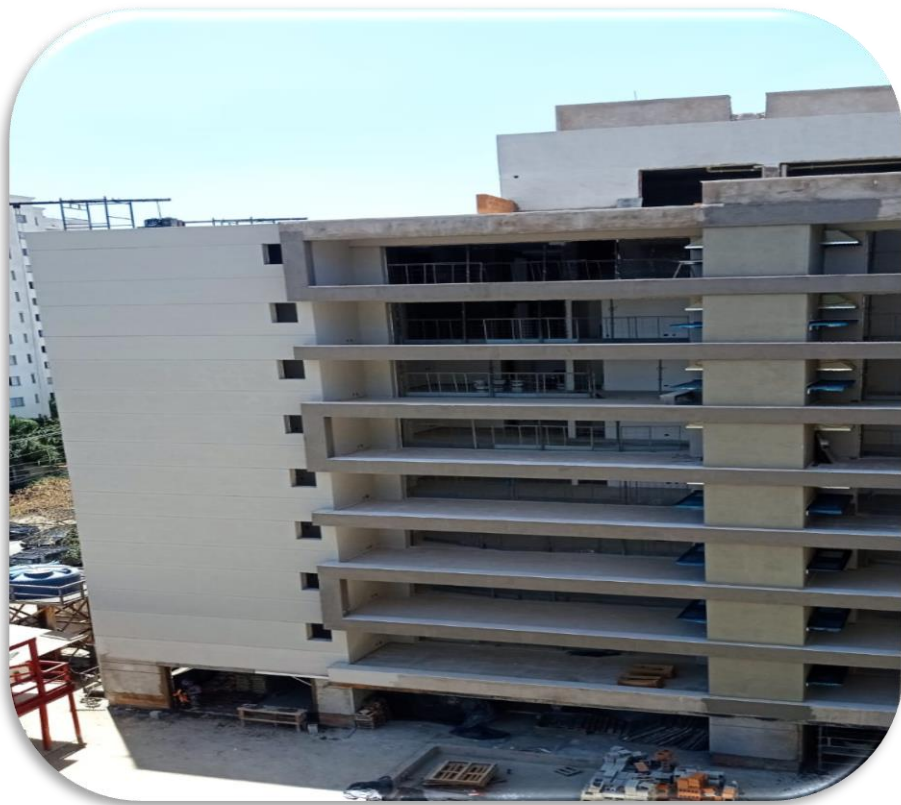
Início de aplicação de revestimento de fachada posterior da Torre – A.
