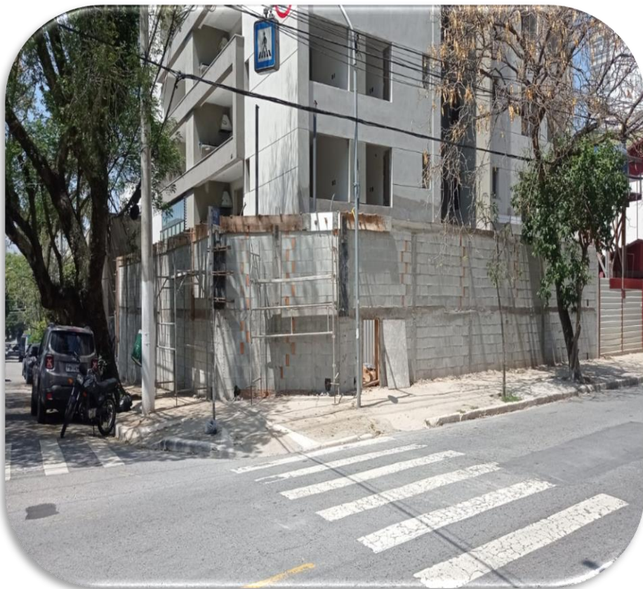
Início de muro de alvenaria em torno do condomínio.
