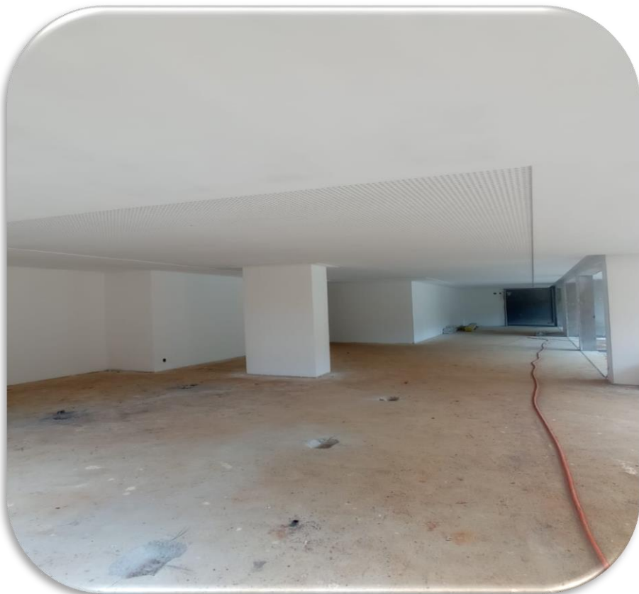
Acabamento no forro da academia Torre - A
