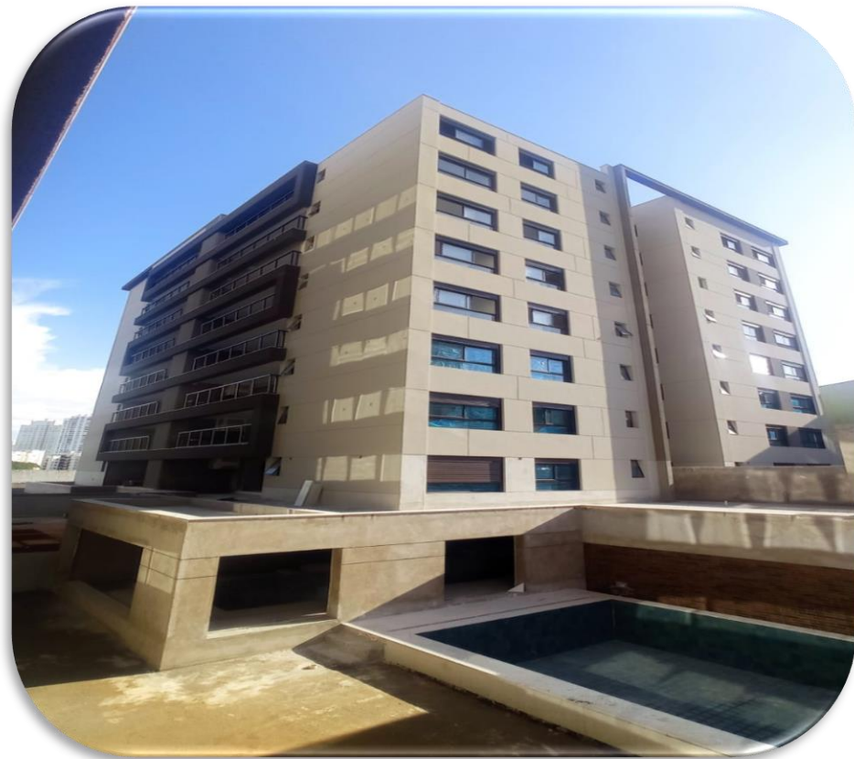
Vista de instalação de guarda corpo Torre –B
