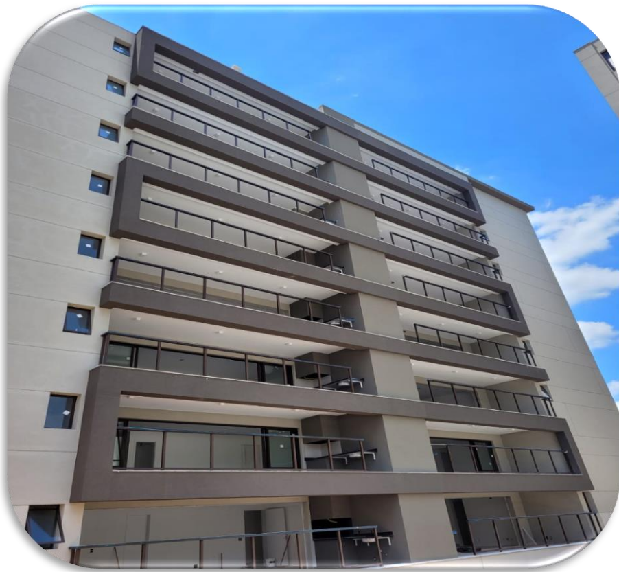
Vista de instalação de guarda corpo e portas de sacada Torre - A
