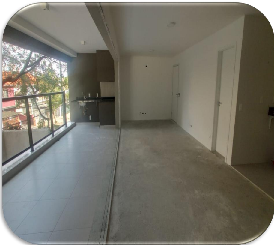
Vista de portas de madeira instaladas Torre - A
