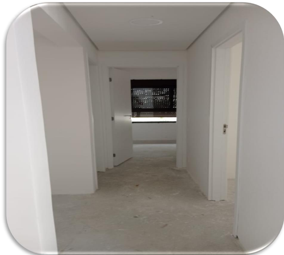
Portas dos dormitórios instaladas
