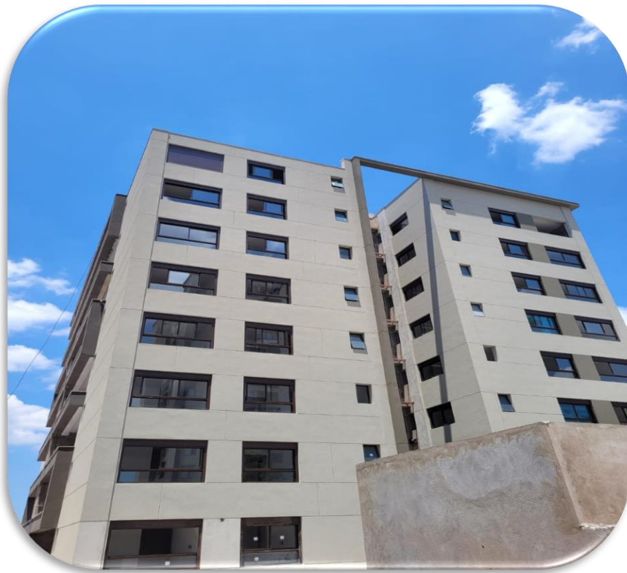
Vista de acabamento de fachada e instalação de caixilhos Torre -B
