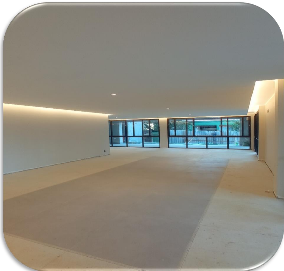
Iluminação e instalação de caixilhos do hall social torre - A
