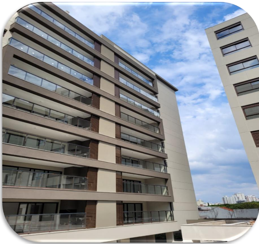
Instalação dos brises, complemento de guarda corpo torre - A
